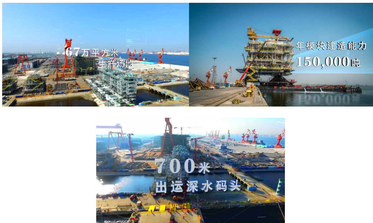
图 1-1 博迈科场地及码头实景图
