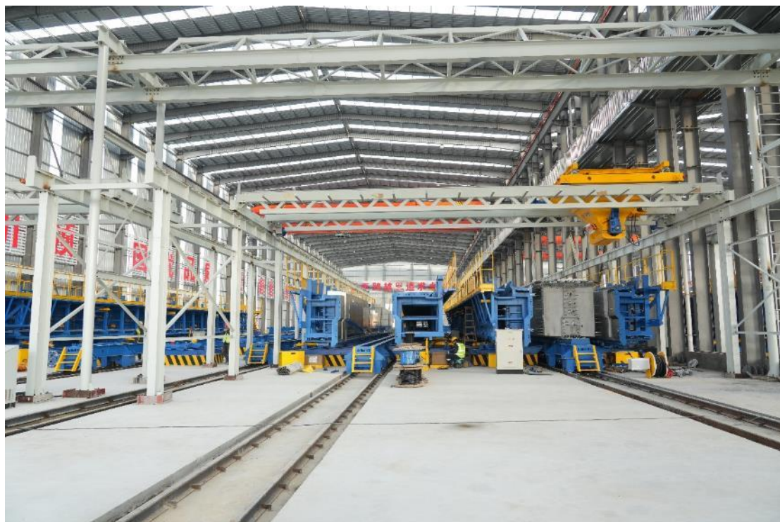
图：T 梁预制场施工实景
