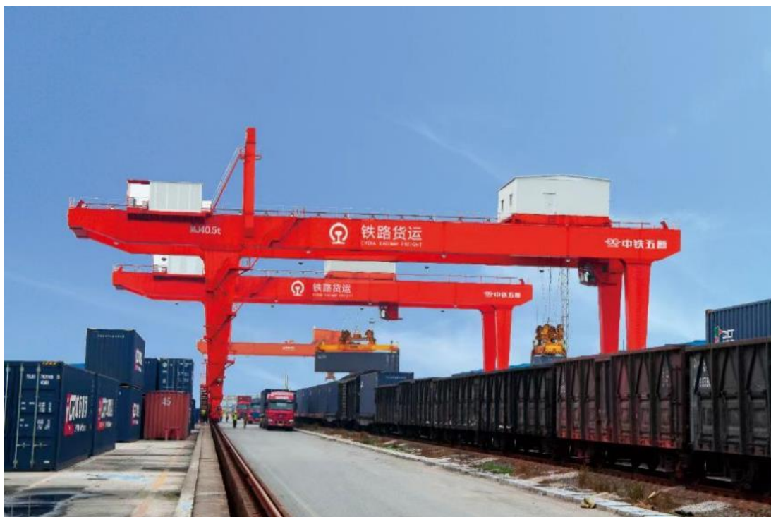
图：铁路货场门式起重机施工实景
