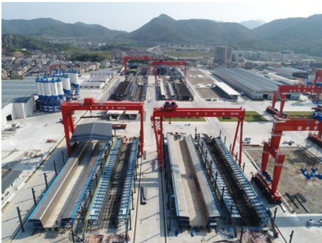
图：整孔梁预制场施工实景
