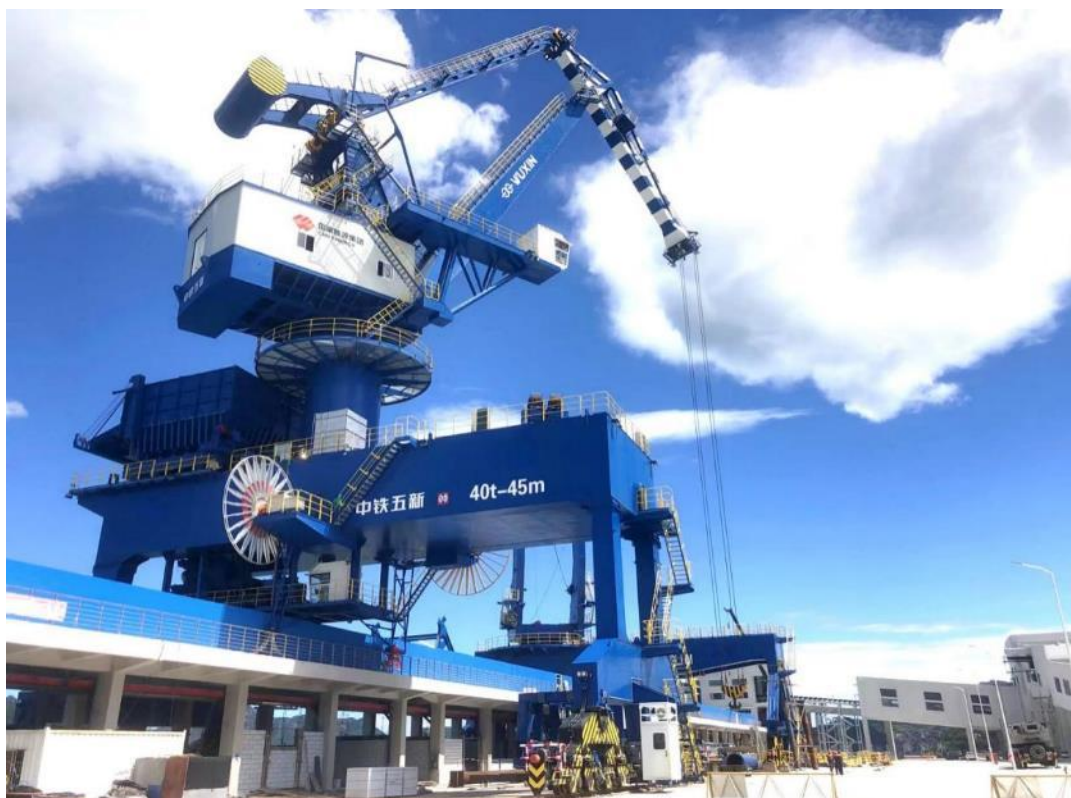
图：带斗门座起重机施工实景
