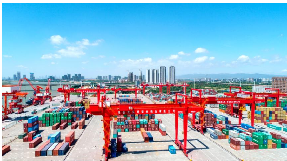
图：轨道式集装箱起重机施工实景
