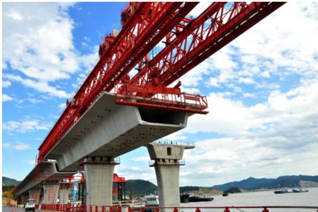
图：节段梁架设实景
