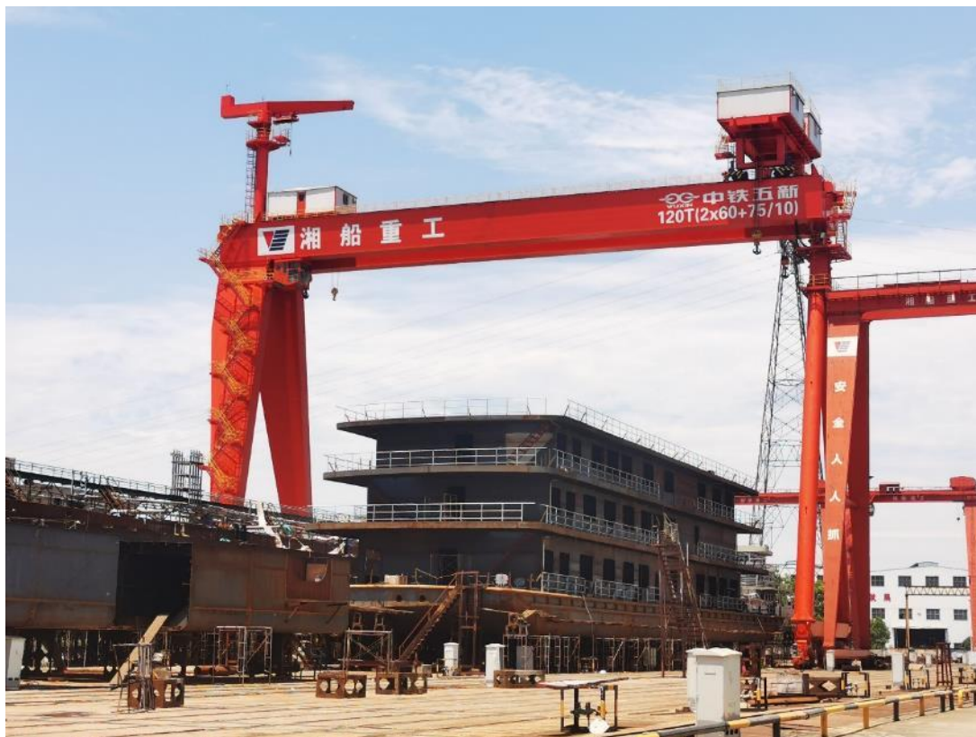
图：造船门式起重机施工实景
