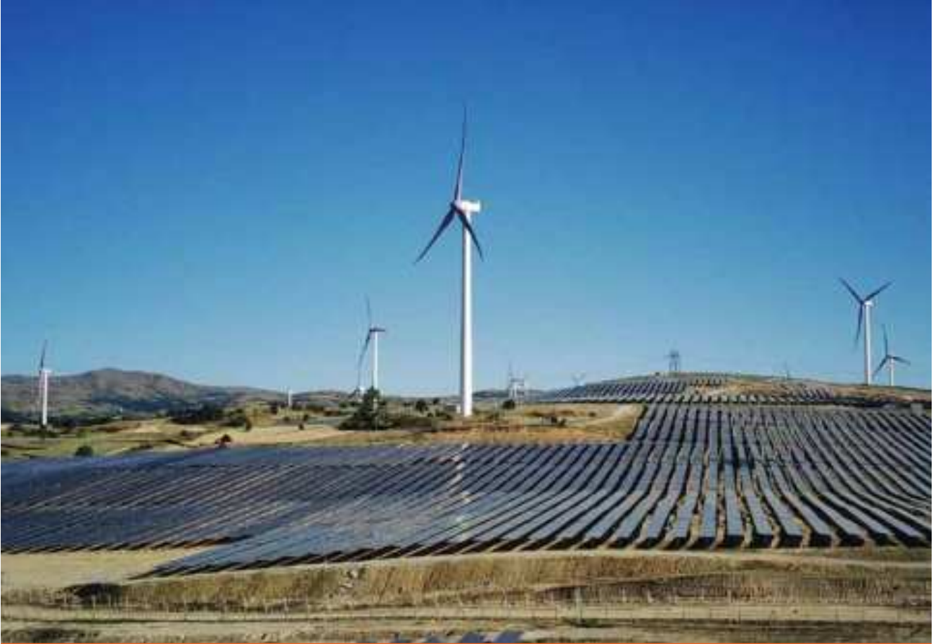
Uşak RES Hibrit GES Santrali
