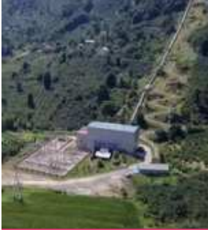
Düzce Aksu HPP
