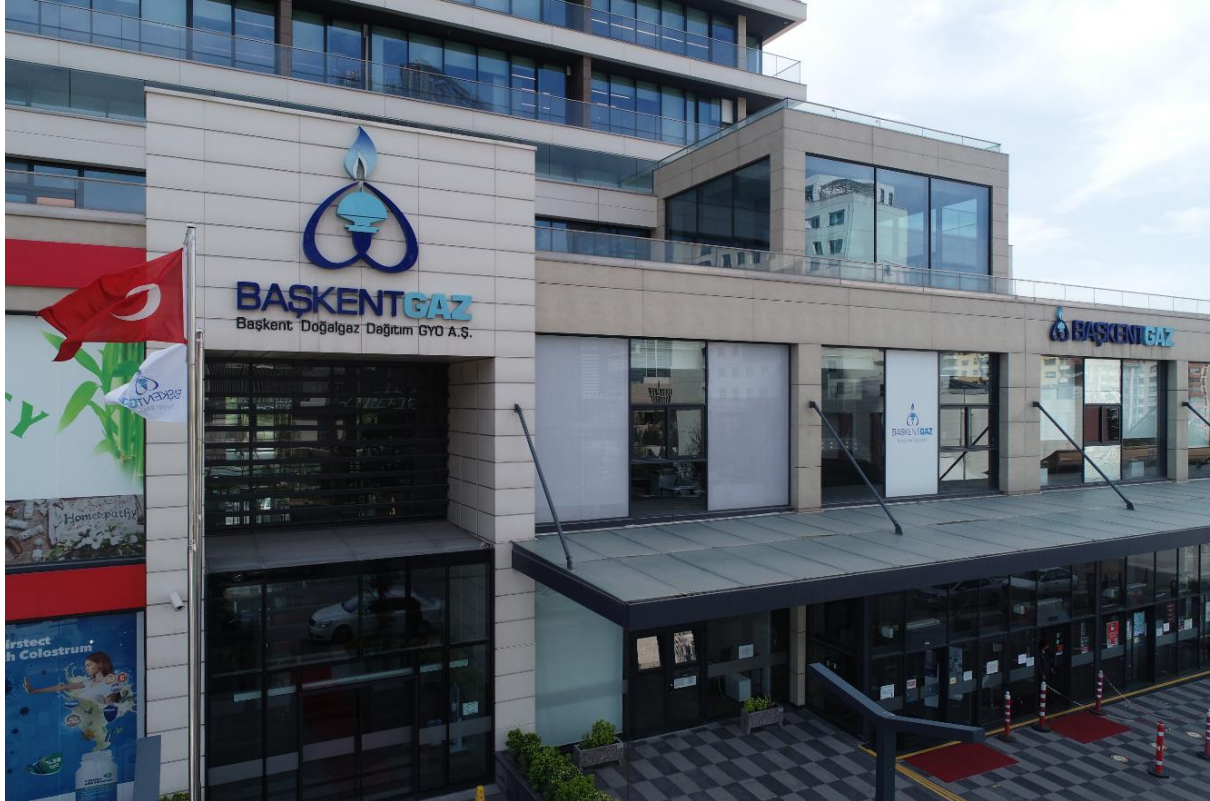
Şekil 35: Başkentgaz Merkez Binası - 1
