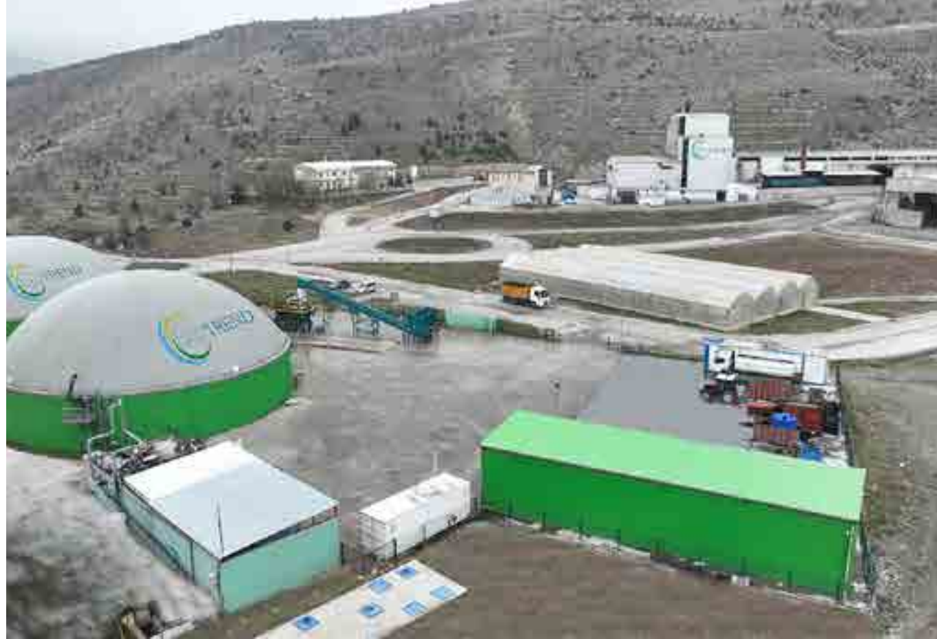
Malatya-1 Çöp Gaz Elektrik Üretim Tesisi Doğu Star Elektrik Üretim A.Ş.
