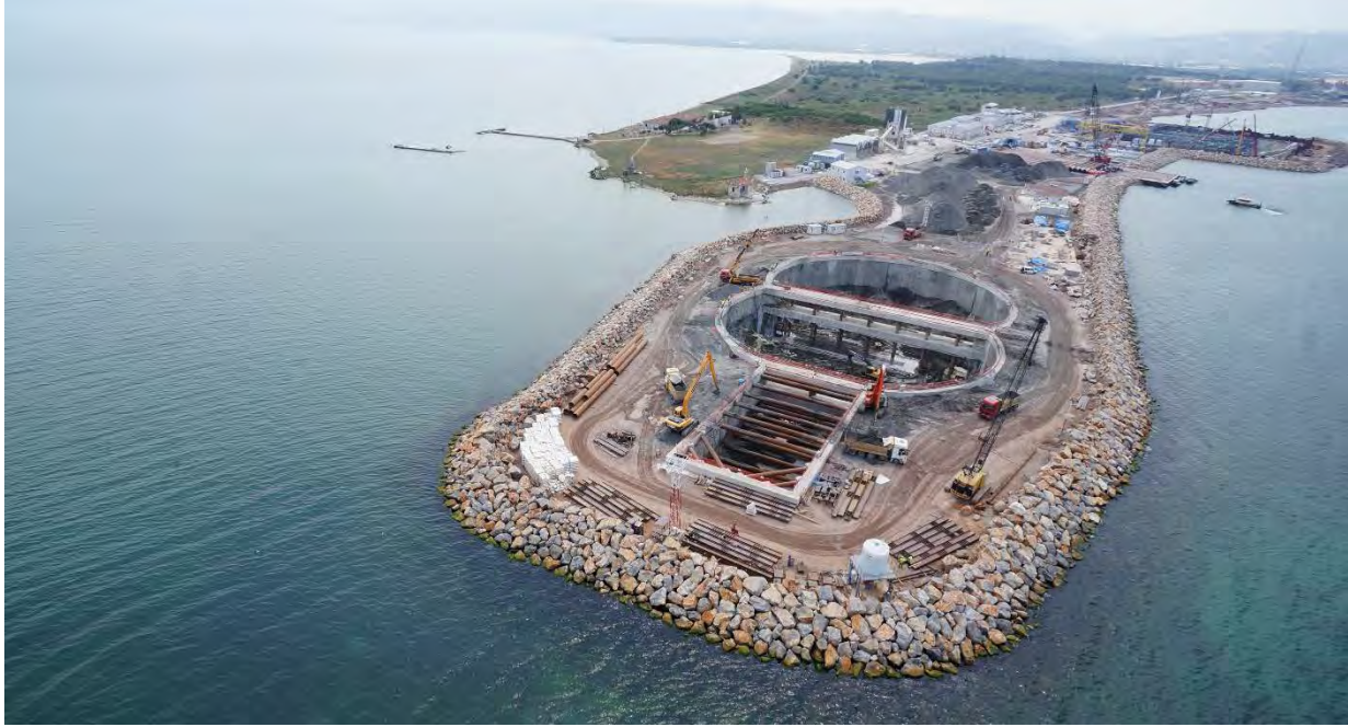
İzmit Körfez Geçiş Projesi Güney Ankraj Bloğu
