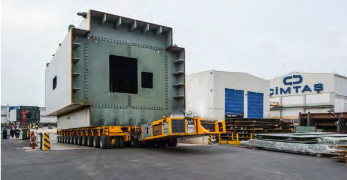
İzmit Körfez Geçiş Projesi, Köprü Ayak Bloğu
