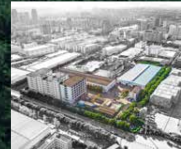
Cimas Ningbo Modular Skids & Pipe Spool - Çin
