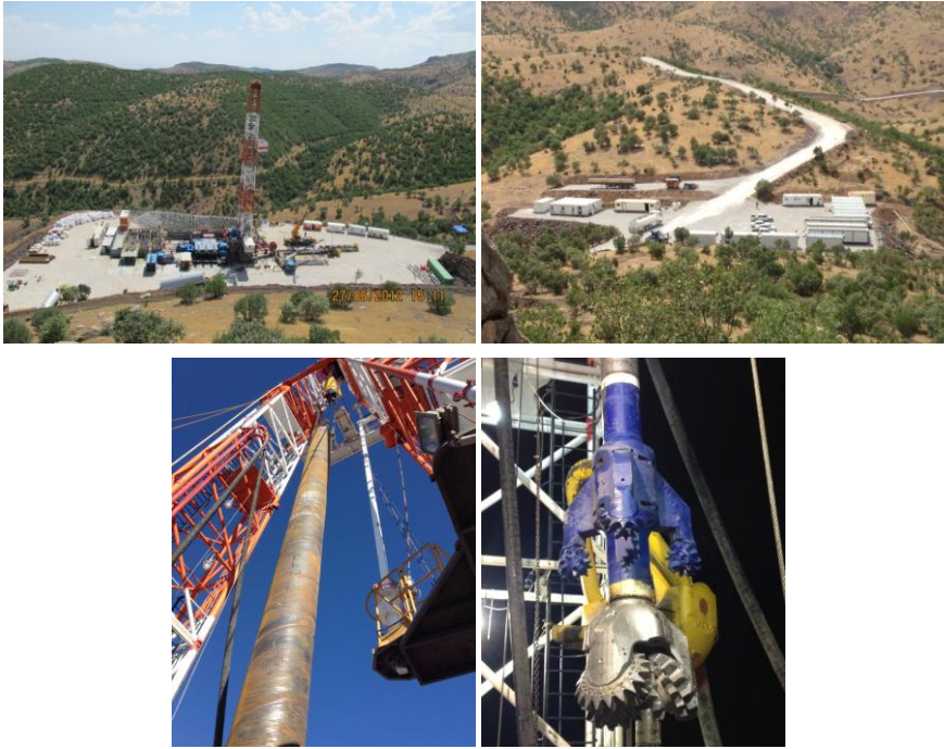
Şekil 1: Koza1 kulesi ve kamp alanı
