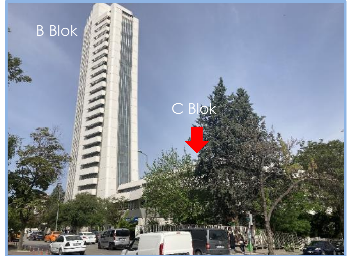
B Blok (Kule) ve C Blok Görünümü
