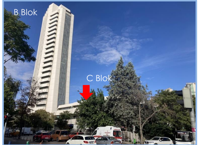
B Blok (Kule) ve C Blok Görünümü
