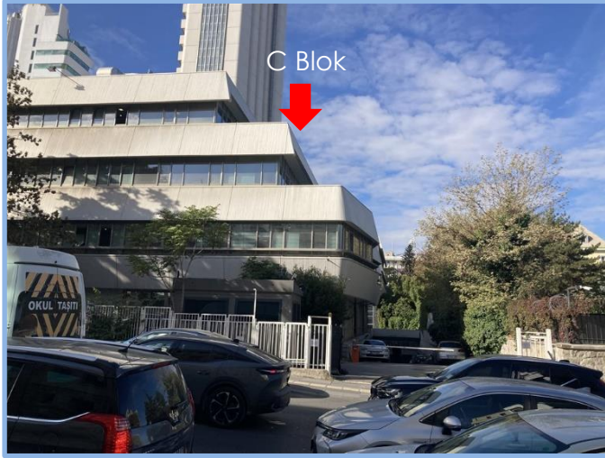
C Blok Görünümü ve Otopark Girişi
