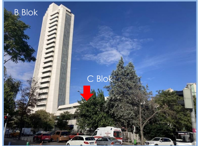
B Blok (Kule) ve C Blok Görünümü
