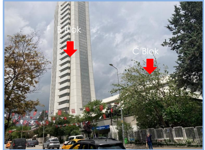
B Blok (Kule) ve C Blok Görünümü
