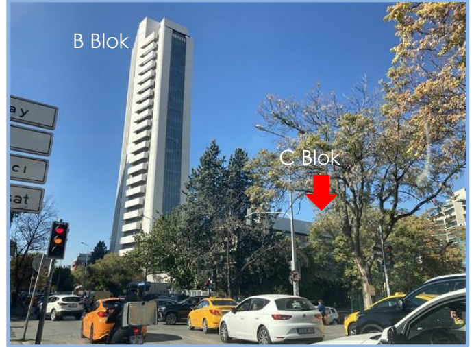
B Blok (Kule) ve C Blok Görünümü
