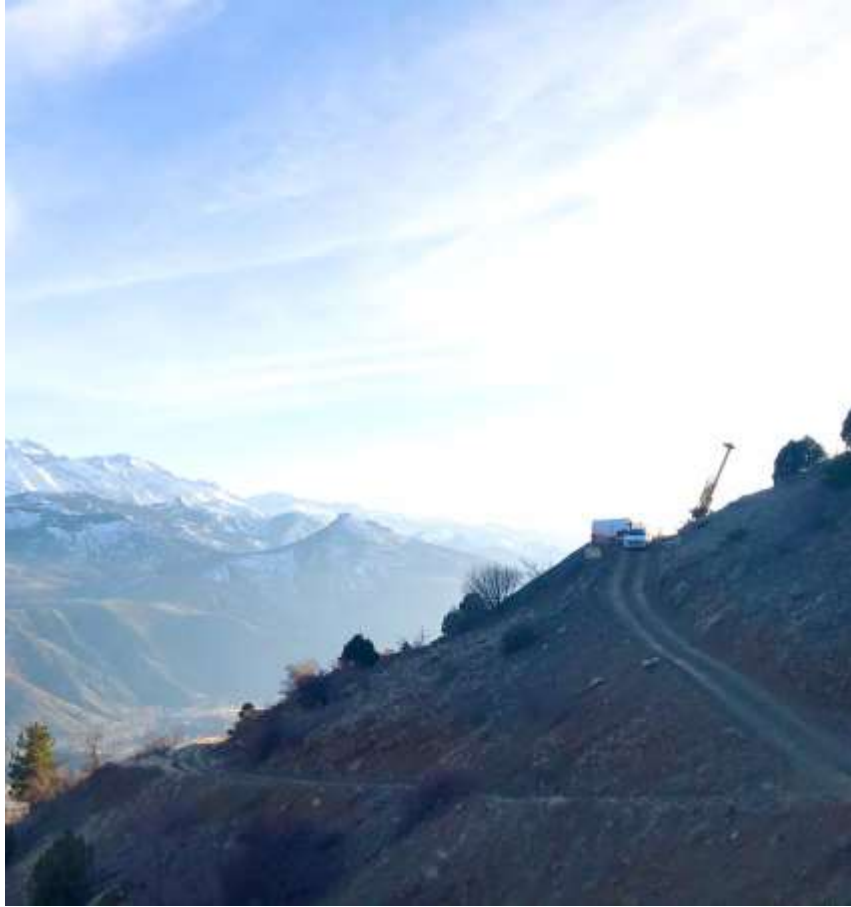
EDDH043 Nolu Sondaj Kuyusunun Uzaktan Görünümü
