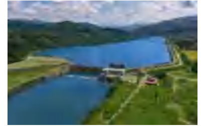
Kumköy Hidroelektrik Santrali
