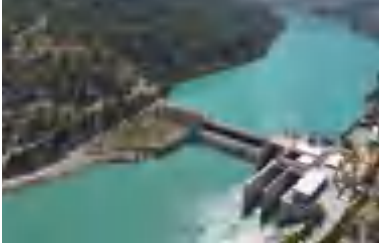
Azmak Hidroelektrik Santrali
