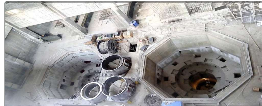
New Umtru H E Project
