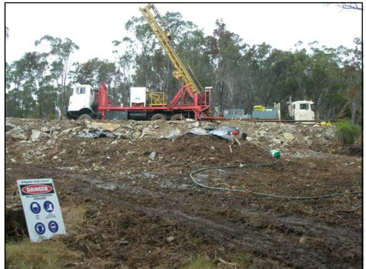
Diamond Drilling at Amamoor Range (Kandanga Nickel Project).
