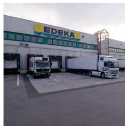
Schillerstraße 51, Ellhofen, Baden-Württemberg
