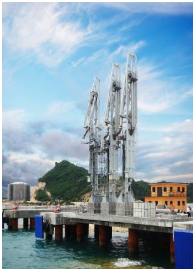
Erection of LNG Loading Arms
