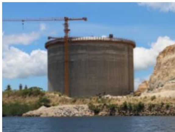
LNG Storage Tank
