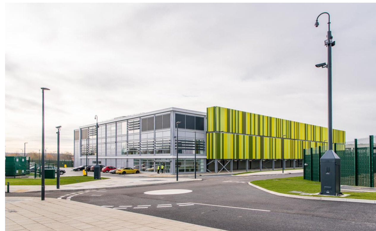
Kao Data Harlow Campus
