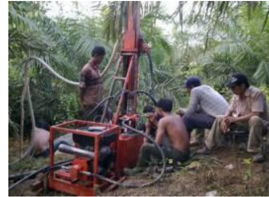
Atan Bara - Drilling DH 6
