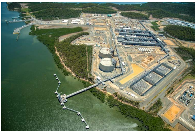
APLNG Curtis Island Site
