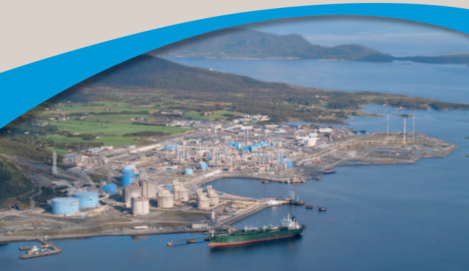
Kårstøanlegget er blant bærebjelkene i det lokale næringslivet og er den daglige arbeidsplassen til rundt 1.000 ansatte.
