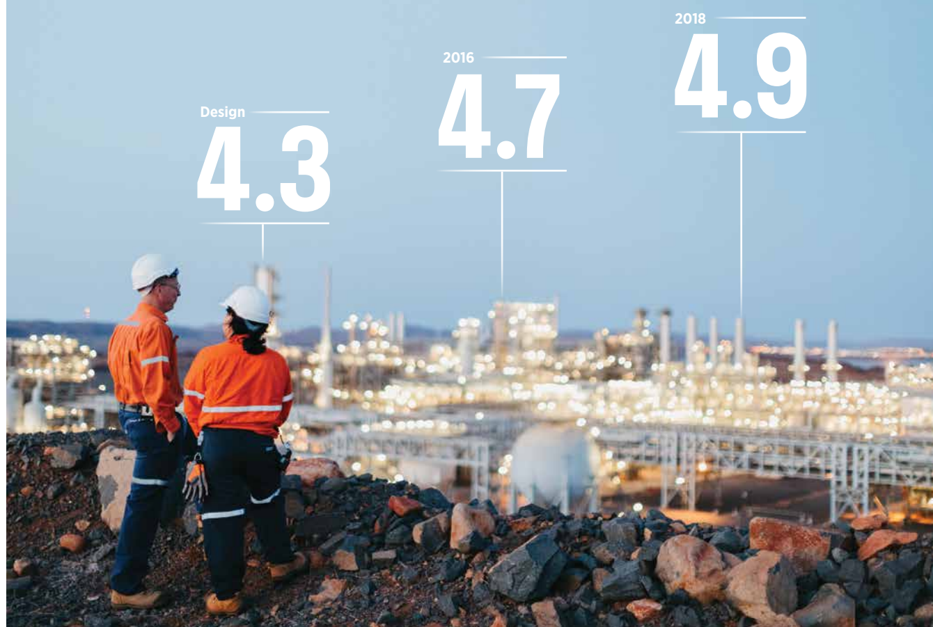
Pluto LNG onshore processing facility
