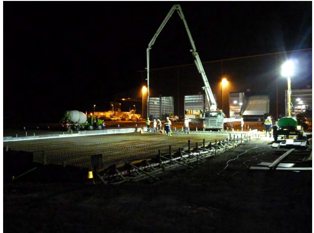
Concrete pour - temporary lube bay
