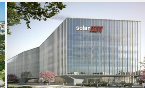
רמת השרון SolarEdge
