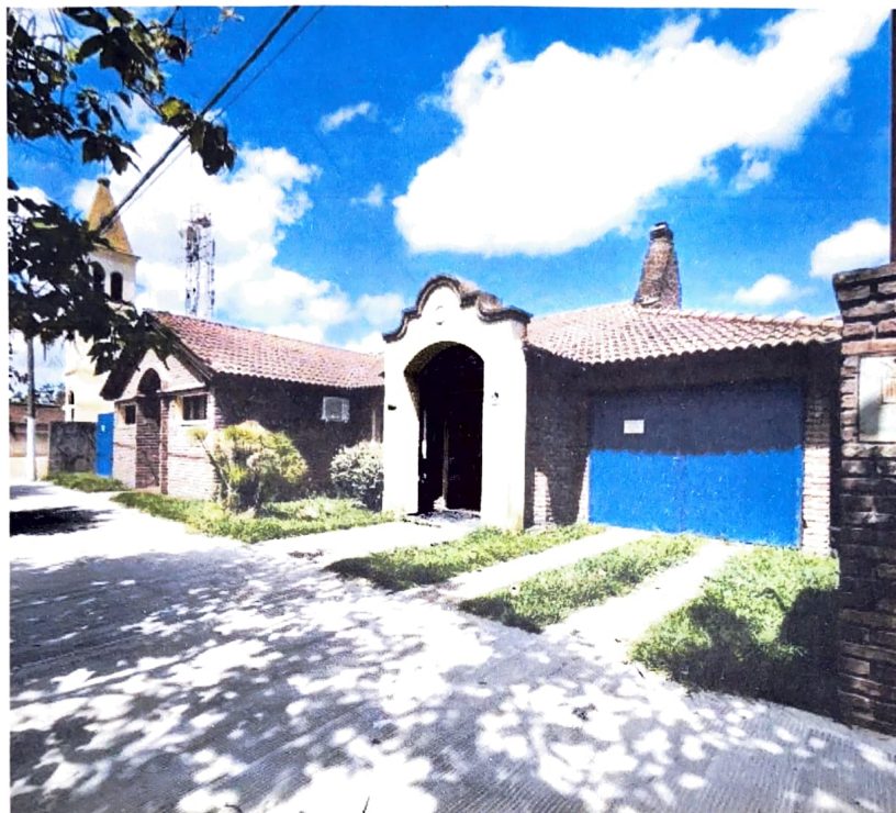
Fachada del laboratorio en el poblado de Carreras – Santa Fe – Argentina.
