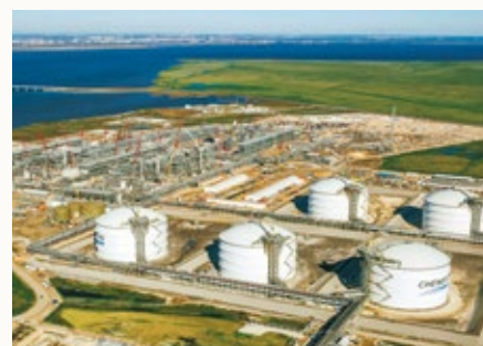
SABINE PASS LNG TERMINAL, LOUISIANA, USA
