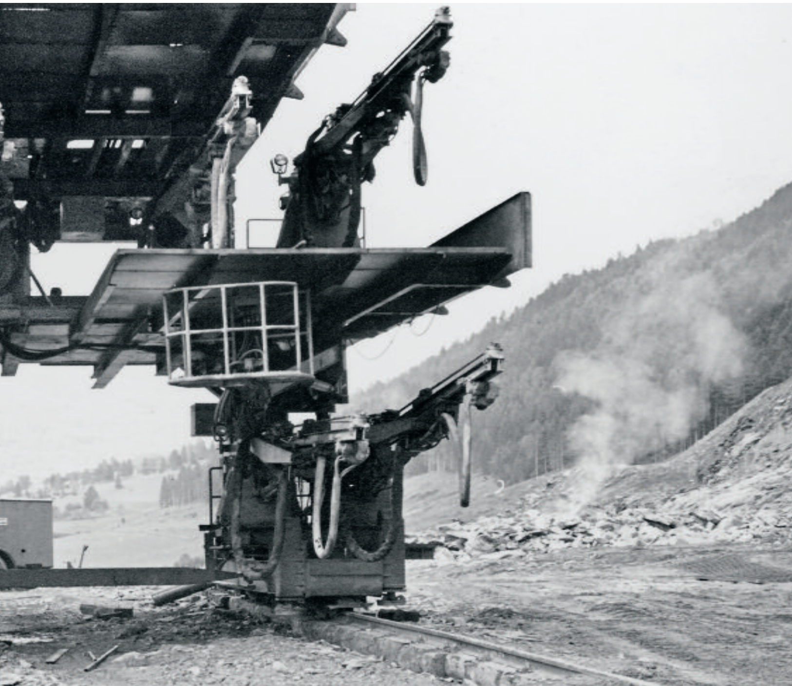
Eingesetzter Bohrwagen beim Tauerntunnel in den 1970er-Jahren
