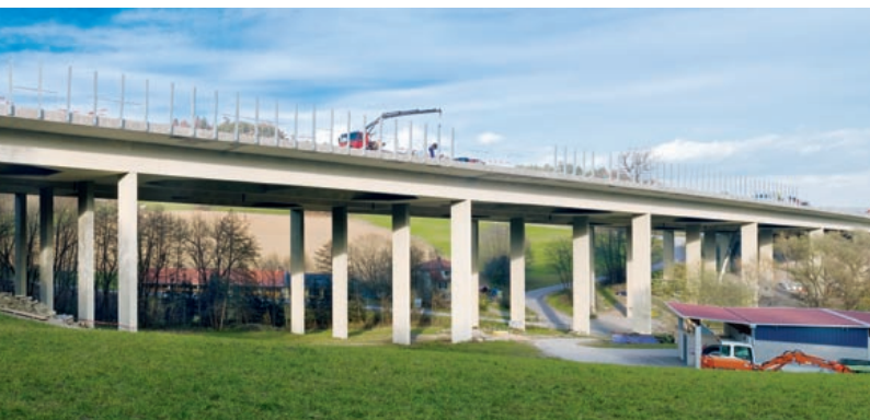
Auf der A 2 Südautobahn, Gleisdorf West – Lassnitzhöhe , werden Straßen- und Brückeninstandsetzungsarbeiten durchgeführt. Diese umfassen Randbalkensanierung, Tragwerksisolierung, Hang- und Betonsanierung.
