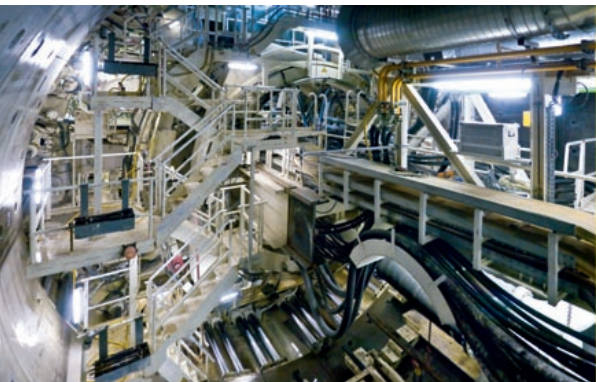
Das Projekt H3-4 Münster Wiesing in Tirol umfasst die Herstellung eines zweigleisigen Eisenbahntunnels von ca. 5.800 m, wobei dieser überwiegend im Hydroschildvortrieb aufgeföhren wird.
