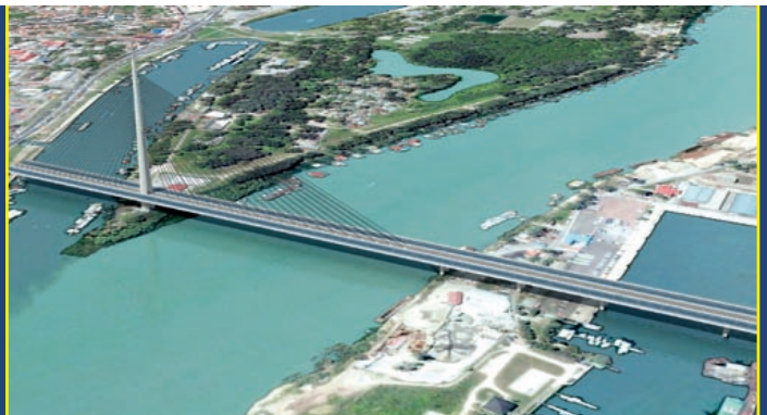
Seit Mai 2008 wird in Belgrad, Serbien, eine 929 m lange Schrägseilbrücke, die Save-Brücke , errichtet. Ein Pylon mit einer Höhe von 200 m wird die Brücke tragen.
