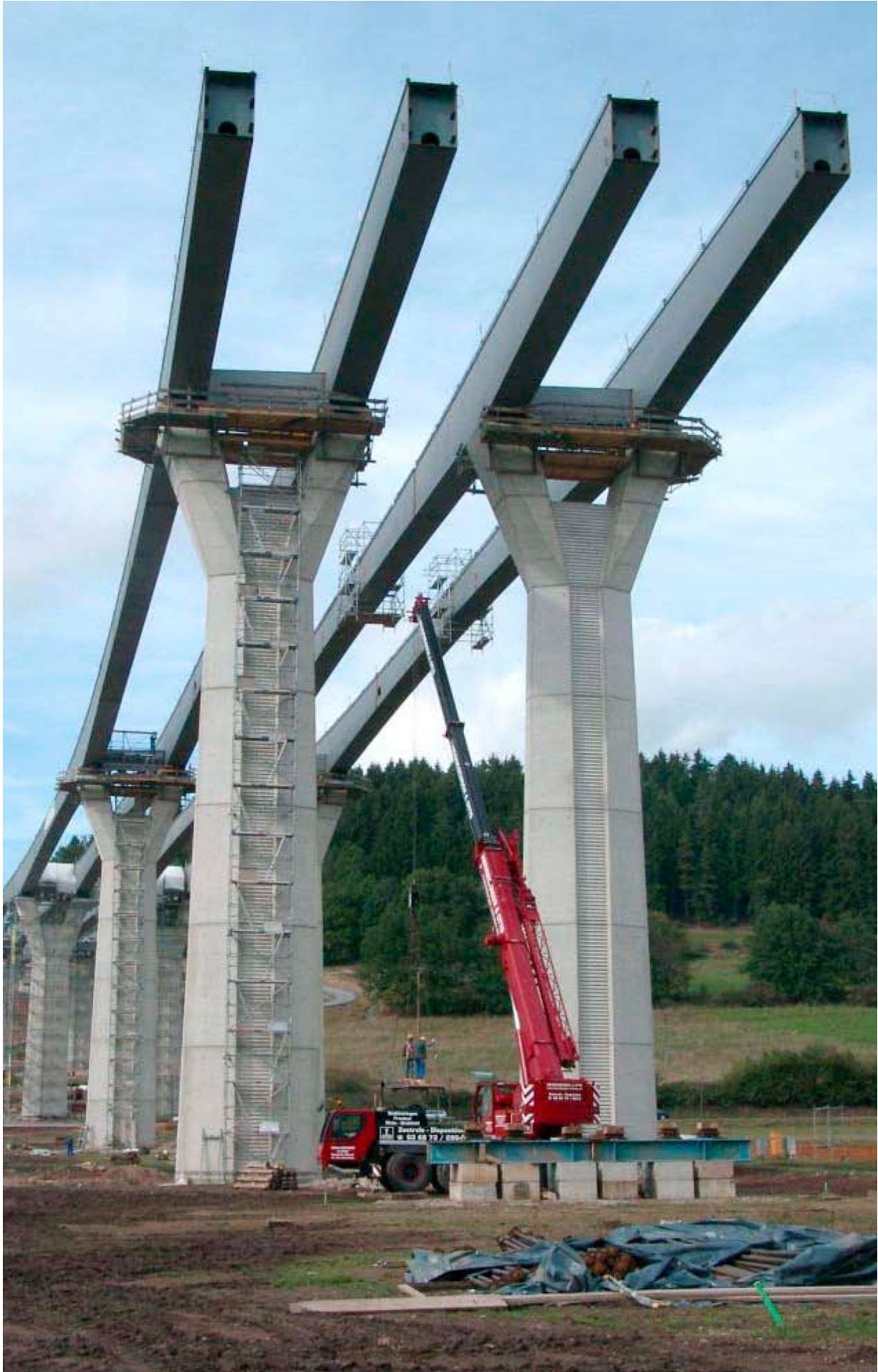
BRIDGE SCHLEUSETAL, SCHLEUSINGEN
