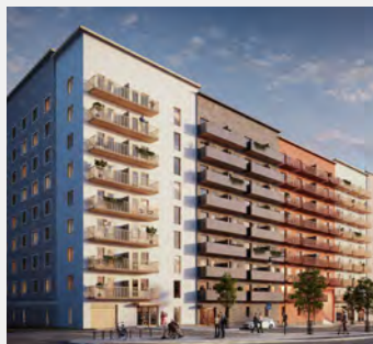
STELLA & NOVA – SÖDRA HÅGGVIK Kommun: Sollentuna Målgrupp: Förvaltningsmarknaden Läge: 30 min till T-centralen Byggnation: 873 lägenheter samt parkeringsgarage och lokaler Projektfas: Byggstart Q1 och Q2 2020
