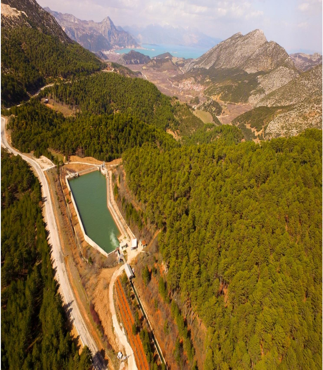
Aksu Enerji Çayköy HES Toplama Havuzu
