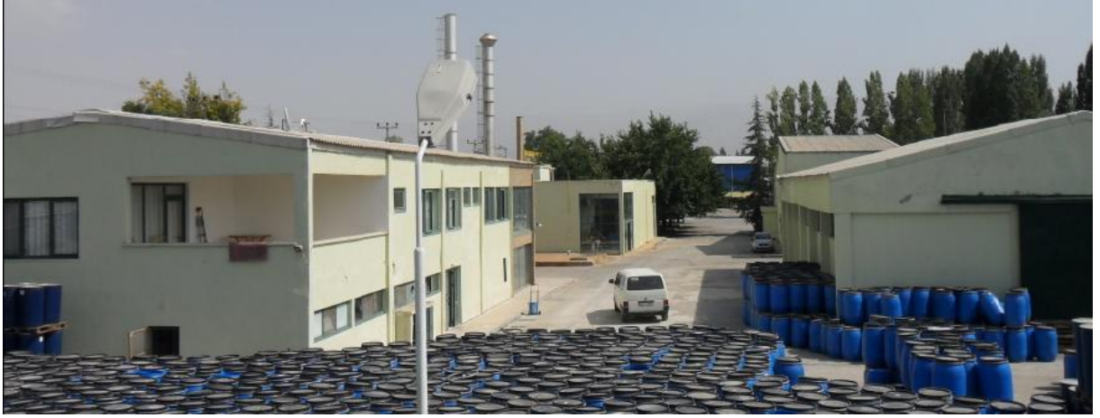
Ersu Fabrikasından Görünüm – P. Varil Sahası
