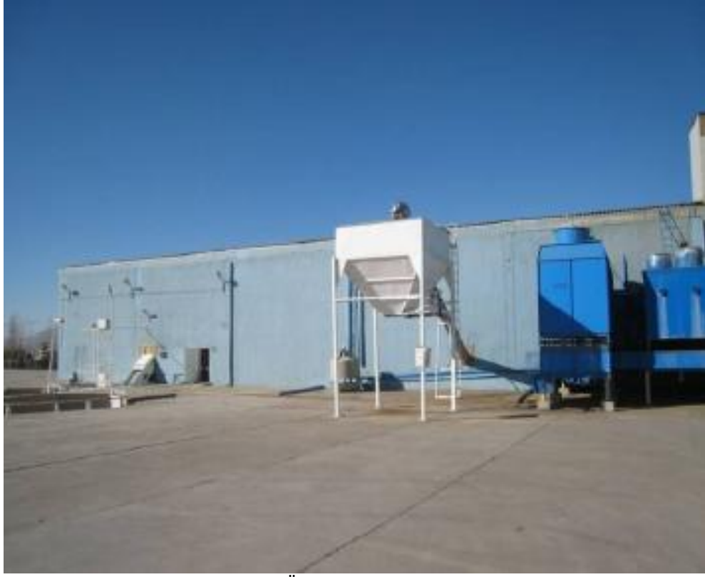
Aksu Fabrikası Üretim Tesisi Yandan Görünüm
