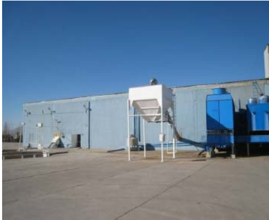
Aksu Fabrikası Üretim Tesisi Yandan Görünüm
