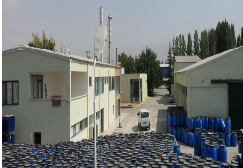
Ersu Fabrikasından Görünüm – P. Varil Sahası
