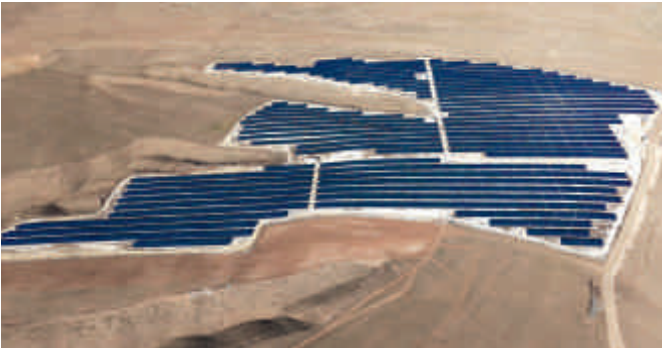
Turkcell Yozgat GES 1
