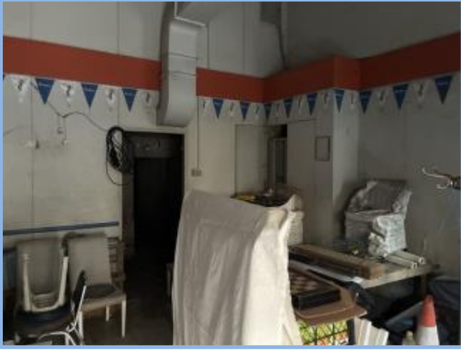
Zemin Kat Görünüm
