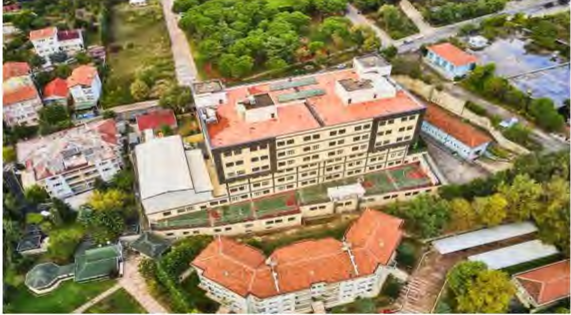
(Taşınmazın arka cephesinin fotoğrafının çekilememesi nedeniyle görsel https://ahesinsaat.com/camluca-kabatas-vakfi-okullari#detail-gallery-5 adresinden alınmıştır.)
