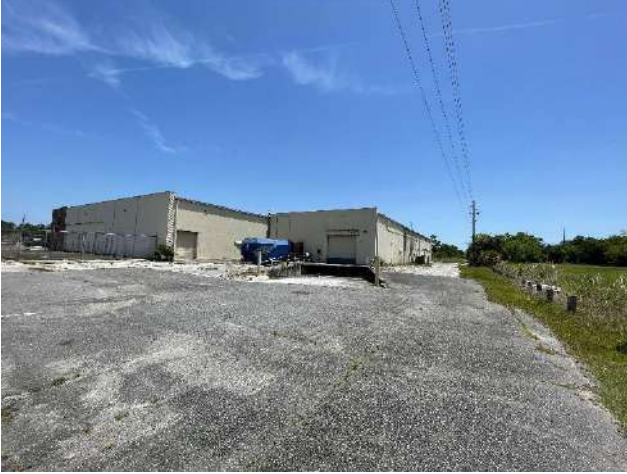
Mevcut Binanın Arkadan Görünümü
