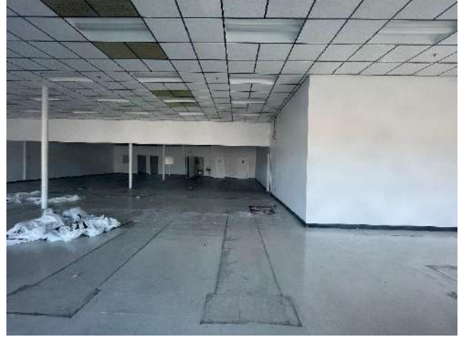
Mevcut Binanın İçi
