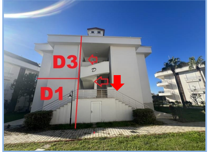
D1 ve D3 Dış Cephe Görünümü
