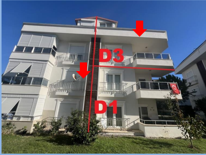
D1 ve D3 Dış Cephe Görünümü
