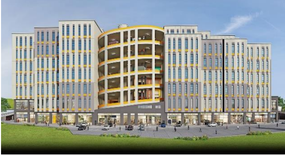
EŞBAH YAPI A.Ş İPEKYOLU PROJESİ
