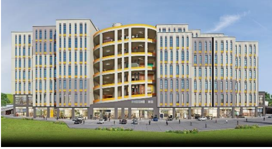
EŞBAH YAPI A.Ş İPEKYOLU PROJESİ
