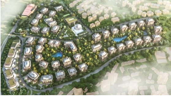
KARANFİLKÖY- KIPTAŞ KENTSEL DÖNÜŞÜM PROJESİ
