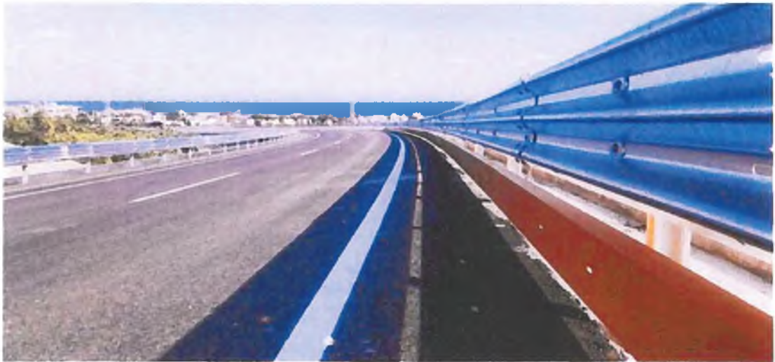
Ses ve Gürültü Bariyerleri İmalatı ve Montajı
