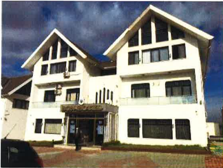
Ana Otel Binası
