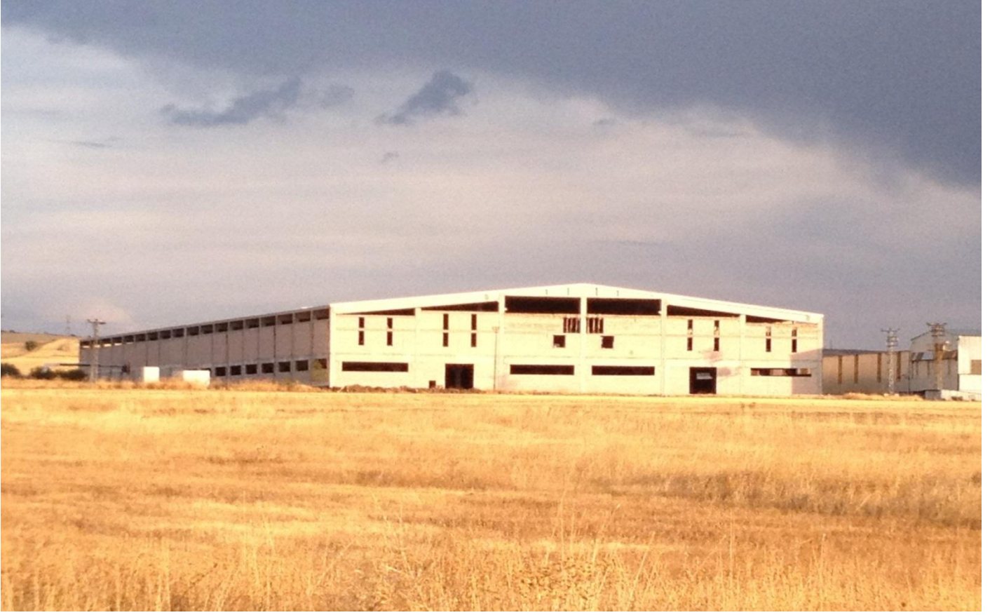
2013'ün ilk çeyreğinde faaliyete geçmesi planlanan fabrika inşaatımız.
