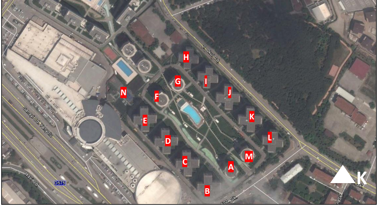
Korupark 1. ve 2. Etap Uydu Görüntüsü
